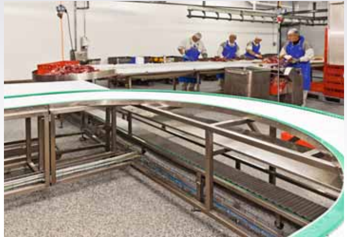
Bei Abattoire in Ettelbruck wurden 0,5 km Fördertechnik verarbeitet./ Half a kilometre of conveyor technology was installed in the production of Abattoire in Ettelbruck.
