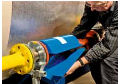
Der Ecojet wird vor dem Brenner auf die Zuleitung montiert.
