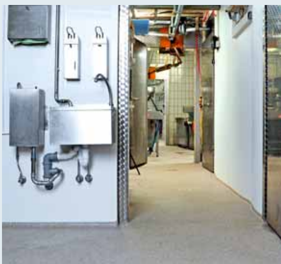
(l.) Gegen die Spannungen zwischen Wand und Boden: Der Wandabschluss erfolgte mittels Kehle direkt auf die Fliesen, möglich dank Silikal Hohlkehlpaste HK 21. (M.) Metzgermeister Dieter Roßmann beim Arbeiten auf dem neuen Boden. (r.) Kleine Tricks mit großer Wirkung: Zwischen Kühlraum und Flur wurde eine Fuge mit Silikal F 10 eingebaut, die Risse des Bodens durch die Temperaturdifferenzen verhindert.
