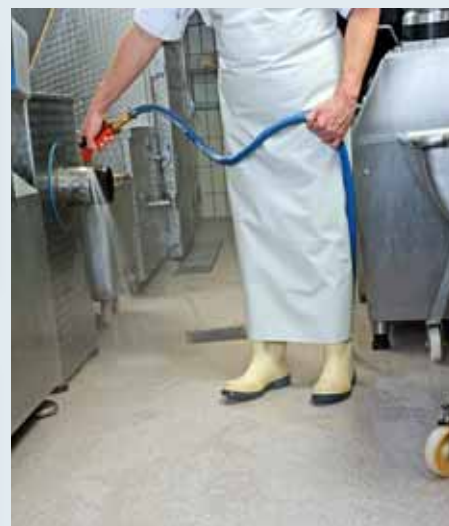
Der neue Boden ist auch bei Nässe rutschfest und lässt sich dank der fugenlosen Oberfläche leicht reinigen.
