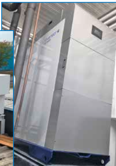
Die Adsorptionskältemaschinen bei Back & Frost. Die Rückkühler geben Abwärme an die Umgebung ab.
