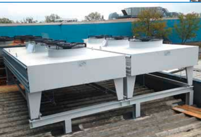
Die Adsorptionskältemaschinen bei Back & Frost. Die Rückkühler geben Abwärme an die Umgebung ab.
