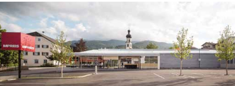
Auch in Natters ist – mitten im Dorf – ein attraktives Gebäude im Passivhaus-Stil entstanden.
