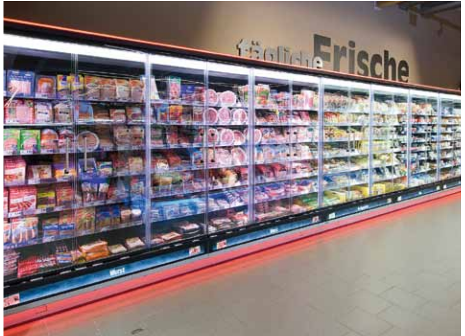
Wandkühlregale mit transparenten und entspiegelten Isoliergläsern bieten nicht nur eine hohe Energieeffizienz, sondern fördern auch den Abverkauf.
