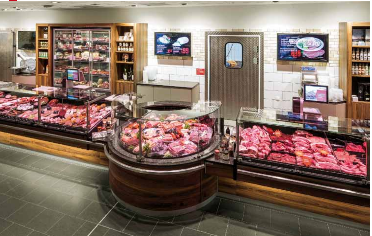
Die umluftgekühlte Theke „AirMaxx“ ist ein Anziehungspunkt im Ladenkonzept von Rewe Kramer im Stadtzentrum von Recklinghausen.
