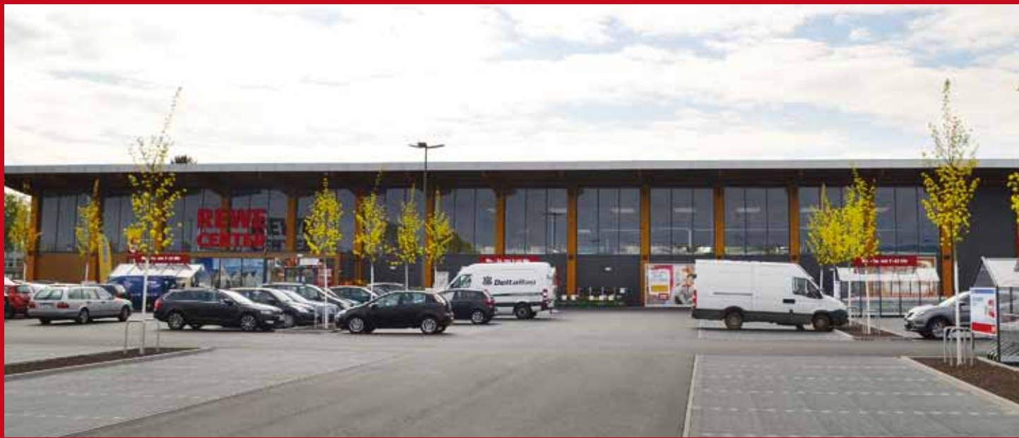
Beim Bau des Praunheimer Marktes wurden nachhaltige und schadstoffarme Baustoffe verwendet.
