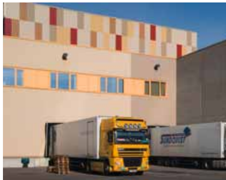
72 < Gebäude & Betriebstechnik Facility & Production Engineering
