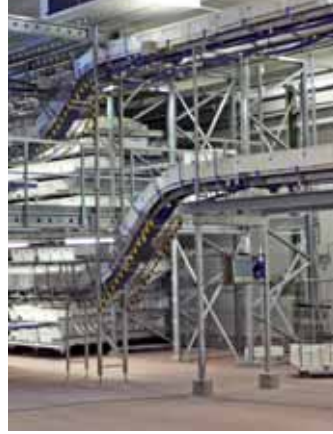
Auch der Einbau einer Lüftungsanlage erfolgte bei laufendem Betrieb./ The installation of a ventilation system was made during production.
