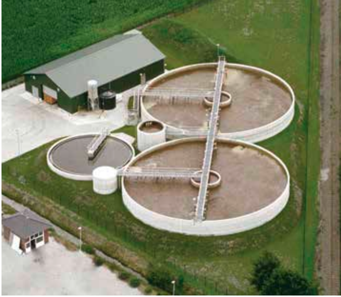
Biologische Reinigung: Mit Betriebsgebäude (grün) als Unterkunft für Anlagenteile (wie Trommelsieb, Flotationsanlage, Schaltwarte, Sandfilter, Schlammverdicker Dekanterzentrifuge, Labor usw.); zwei große identische Belebungsbecken (Biologie) mit begehbare Brücke. Ein etwas kleineres Becken mit kleiner Brücke ist das Nachklärbecken.
