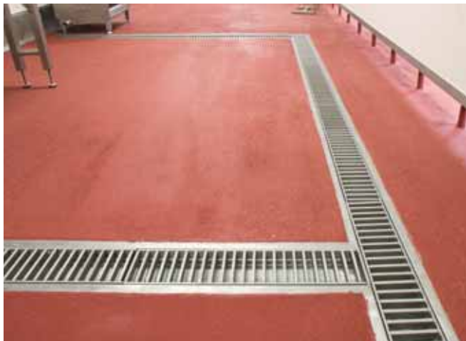
Fotos: Wiedemann-Technik, APC, Rentschler Reven
