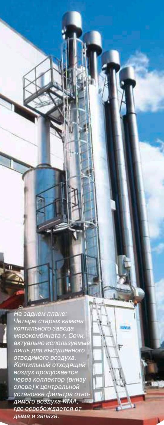
На заднем плане: Четыре старых камина коптильного завода мясокомбината г. Сочи, актуально используемые лишь для высушенного отводимого воздуха. Коптильный отходящий воздух пропускаться через коллектор (внизу слева) к центральной установке фильтра отводимого воздуха КМА, где освобождается от дыма и запаха.
