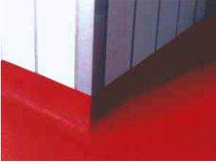
Промышленные полы должны быть бесшовными и закругленными наверх у стен.
