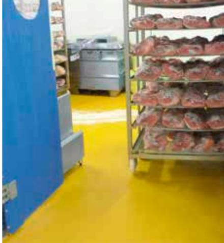
образовываться маленькие трещины, которые перед началом работы на таких поверхностях должны быть заполнены синтетической смолой. Вследствие низкой химической стойкости и проблем с точки зрения гигиены бетонные полы необходимо дополнять подходящим настилом.
