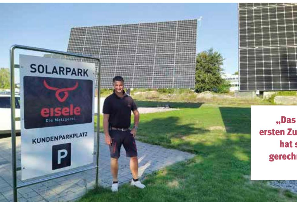
Das Energiesystem der Metzgerei Eisele besteht aus drei Photovoltaik-Anlagen mit 115 kWp, einem Blockheizkraftwerk, einem E-Auto samt mehrerer, auch öffentlich zugänglicher Ladesäulen und zwei Speichern mit Pacadu-Technologie. Unten die Trucks.
