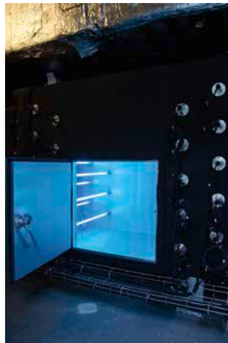
UV-C-Umluftdesinfektionsgeräte (Bild li.) von Sterilsystems sind bei Berger Schinken ebenso im Einsatz wie die TR-Systeme (re.), die in der Lüftung verbaut sind. / UV-C circulating air disinfection equipment (left pic.) from Sterilsystems is used at Berger Schinken, as are the TR systems (r.) in the ventilation.
