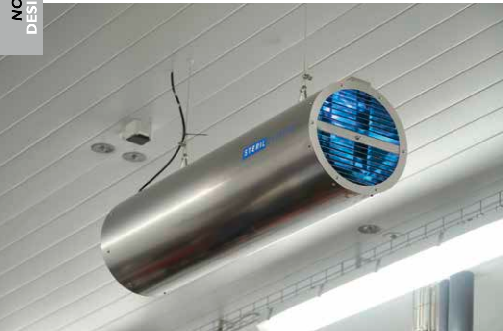
UV-C-Umluftdesinfektionsgeräte (Bild li.) von Sterilsystems sind bei Berger Schinken ebenso im Einsatz wie die TR-Systeme (re.), die in der Lüftung verbaut sind. / UV-C circulating air disinfection equipment (left pic.) from Sterilsystems is used at Berger Schinken, as are the TR systems (r.) in the ventilation.
