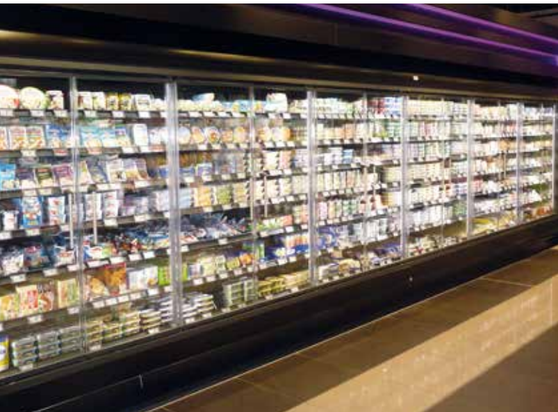
Produkte, die wie Sahne oder Butter nicht so häufig gekauft werden, liegen wegen der Energieeffizienz hinter Glastüren.
