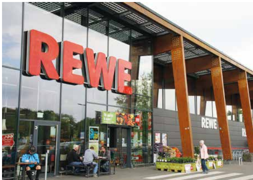
Durch die lange Fensterfront und die 18 Dachlichtkuppeln kommt viel Tageslicht in den Markt in Berlin-Rudow. Künstliches Licht wird nur so viel zugeschaltet, wie nötig ist.
