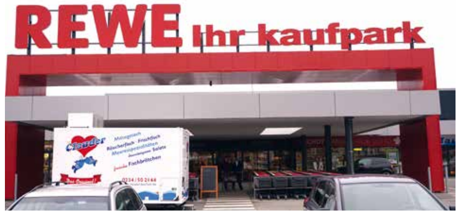
Trotz wirtschaftlicher Erfolge mit Spitzenumsätzen sind irgendwann ladenbauliche Veränderungen unvermeidlich. In der Bochumer „Kaufpark-Ihr Rewe-Filiale“ hat man in nur knapp vier Wochen einen komplett neuen Markt erstellt.
