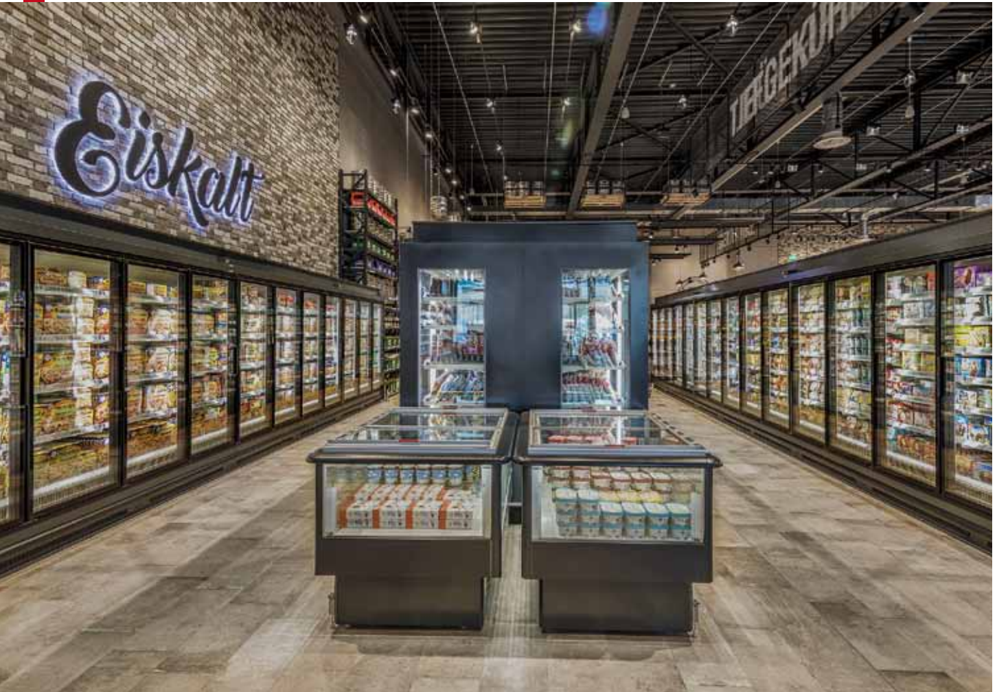
Für eiskalte Frische sorgen im Schmidt's Markt XL in Bad Säckingen 35 hochmoderne Kühlmöbel. von Viessmann.
