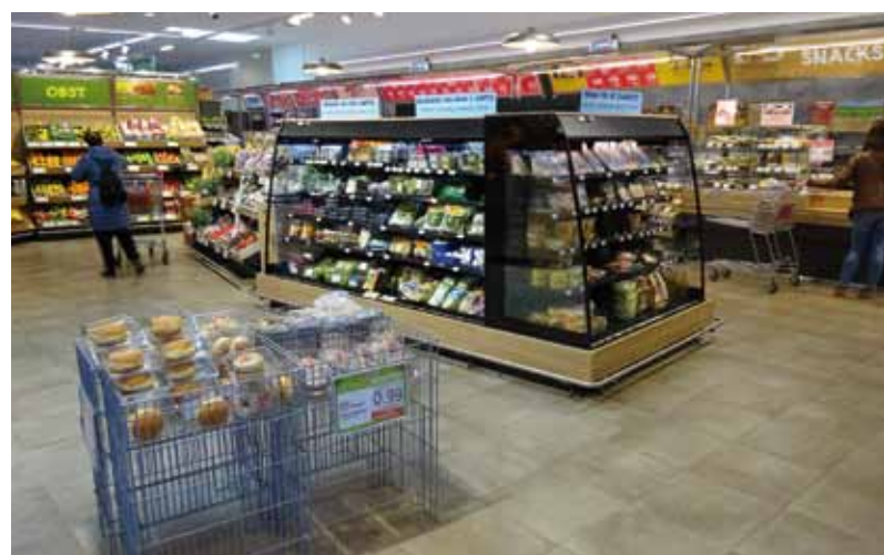
Im Eingangsbereich werden in einem offenen Kühlregal frische Salate, Säfte und – in der Filiale zubereitete – Tramezzini angeboten.
