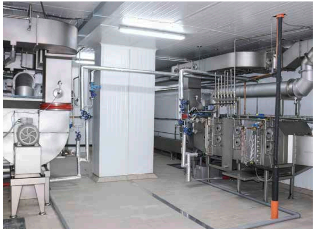
Fotos: Vemag Anlagenbau/Salbac
